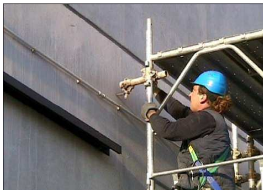
Ancoraggio con barra munita di gancio
