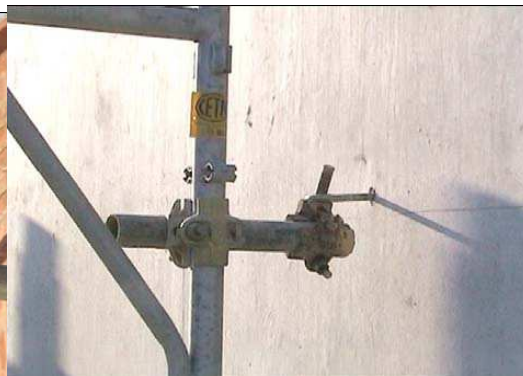
Ancoraggio a barre filettanti passanti dotate di piastre di contrasto
